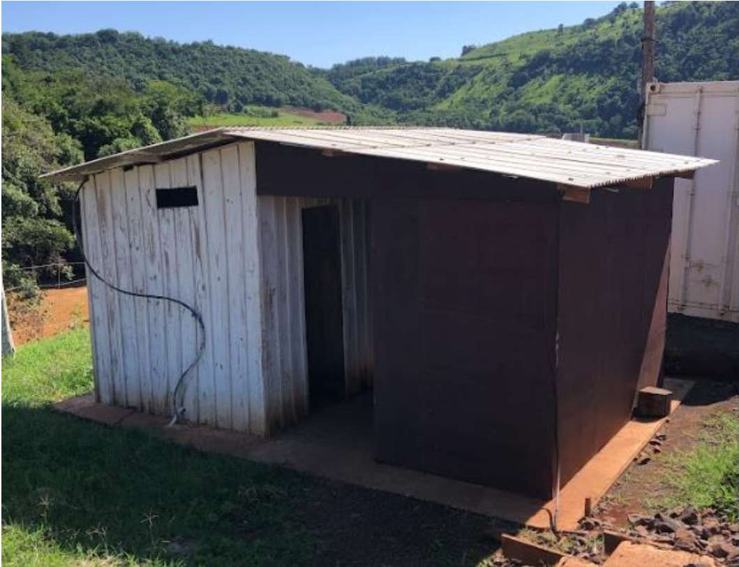
Figura 3 - Banheiros na CGH Tapera 2A.
