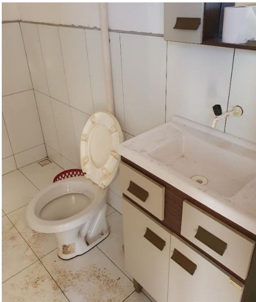
Figura 5 - Banheiro na Casa de Força.
