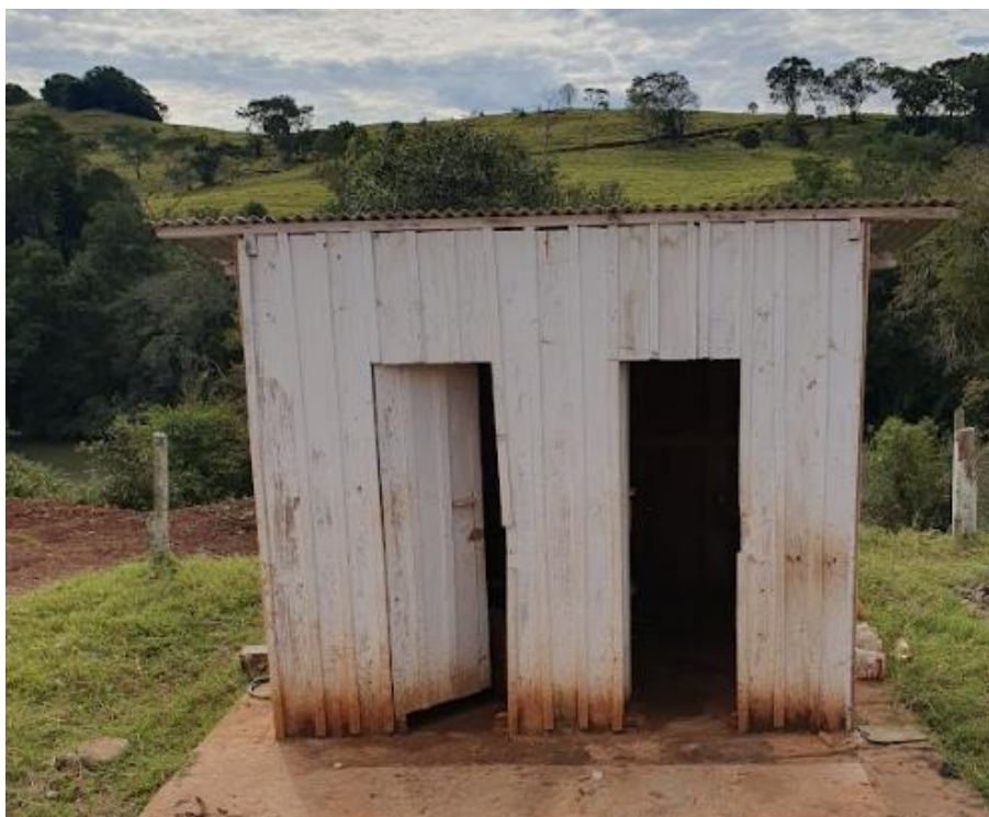
Figura 3 - Banheiro fixo no canteiro de obras.
