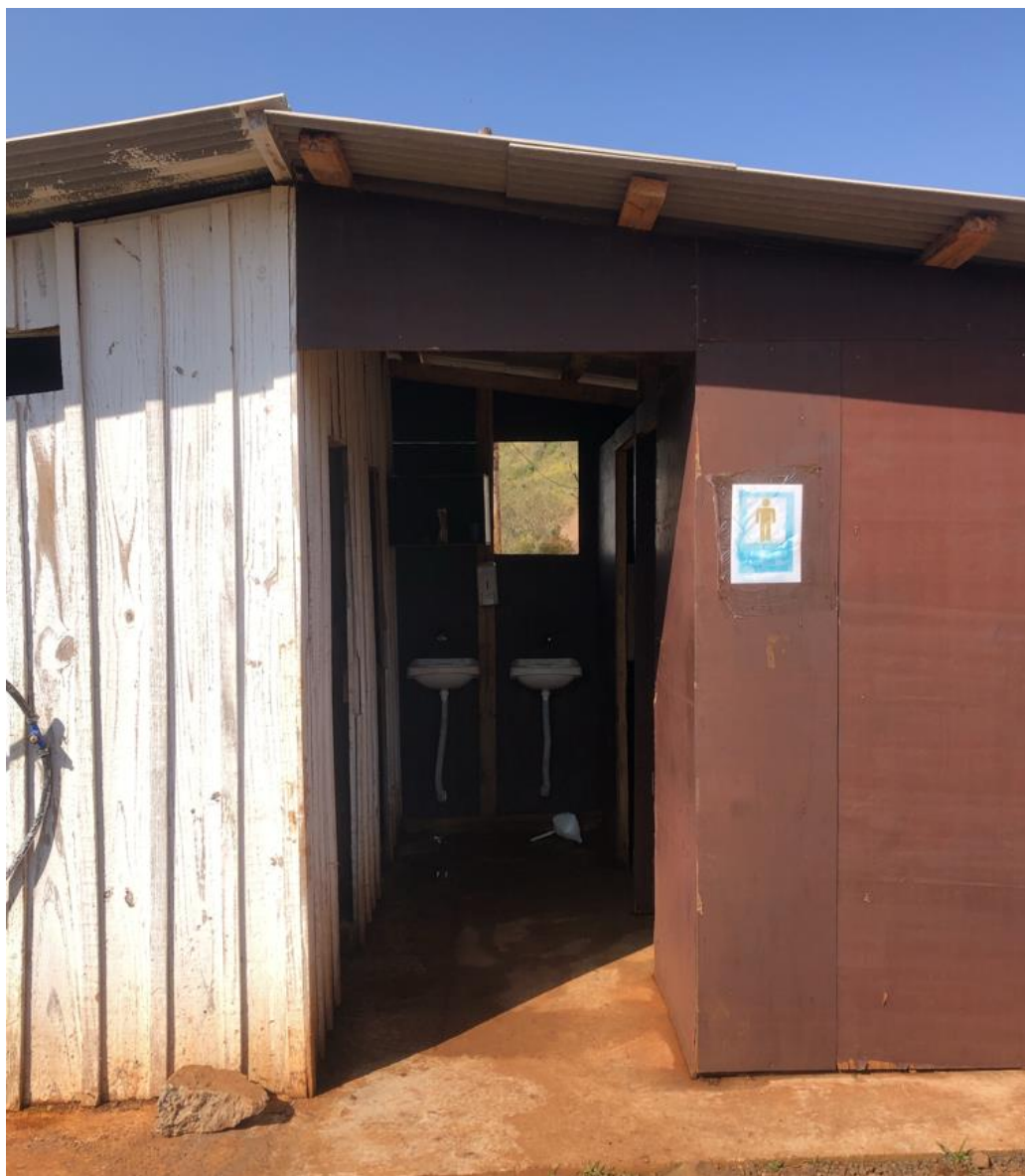
Figura 3 - Banheiros na CGH Tapera 2A.
