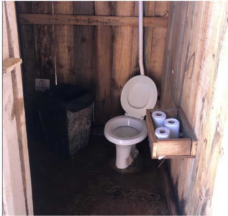
Figura 4 - Banheiro na CGH Tapera 2A.
